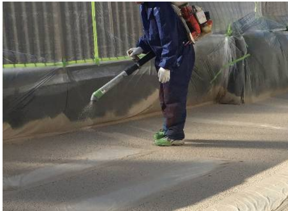
滑り止め骨材撒布状況
