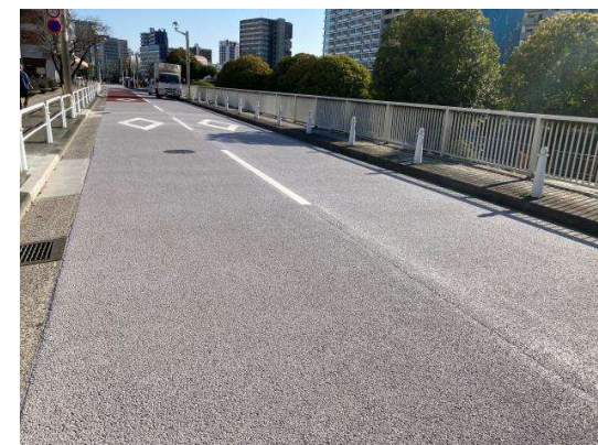
車道への施工事例
